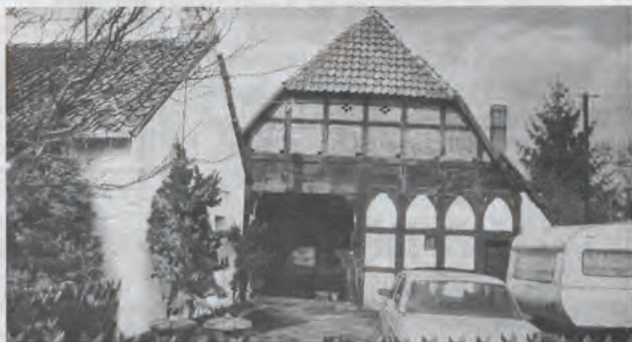
Nur noch wenig ist heute von der Schönheit des Hauses Pinkenburger Straße 3 mit dem Satteldach, den Spitzbögen und den derben Eichenbalken zu erkennen.
